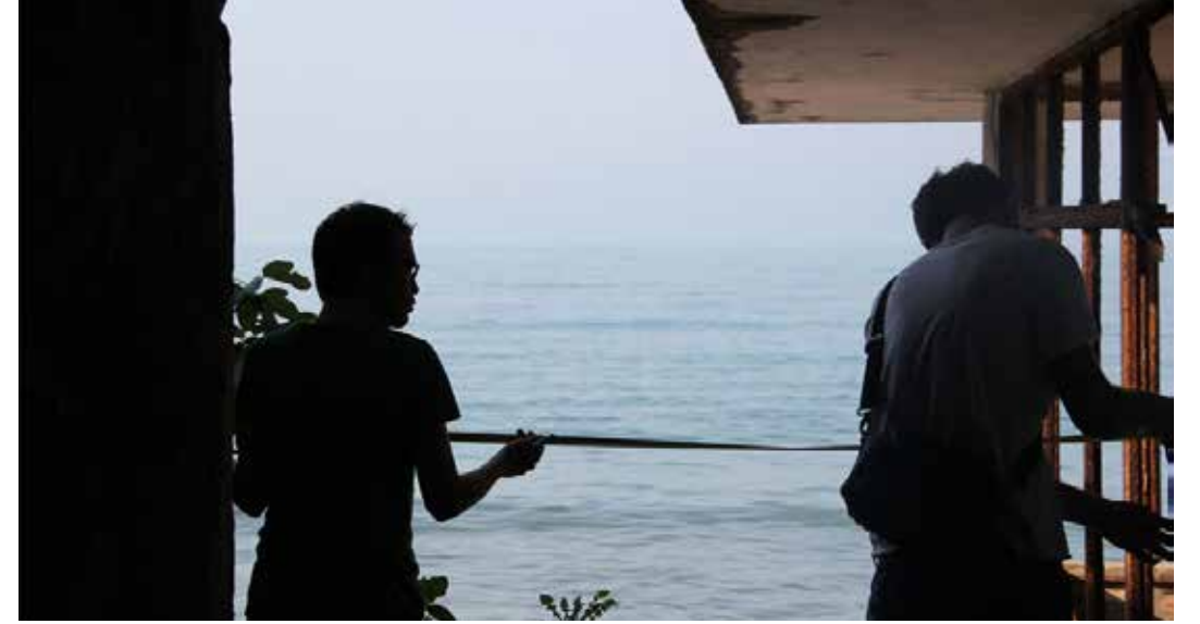
Figür 15: Çaka'da röleve çalışması 14-Çaka'da röleve çalışması
