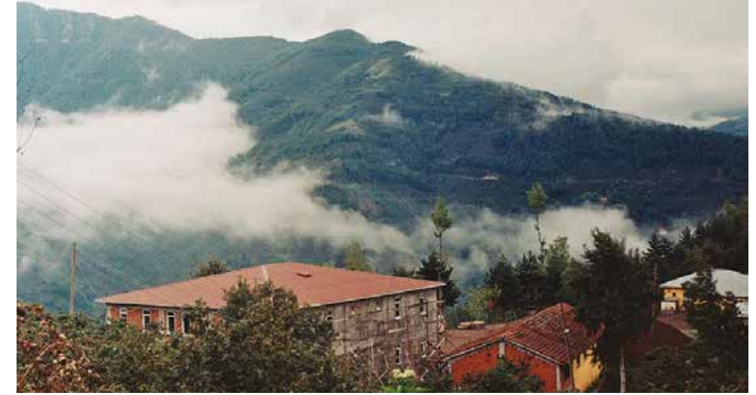
Figür 6: Ordu Kargı'da yarım kalmış okul inşaatı
