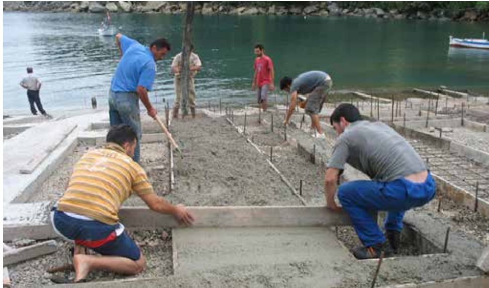
Figür 4: Balıkçı barınakları uygulama çalışmaları
