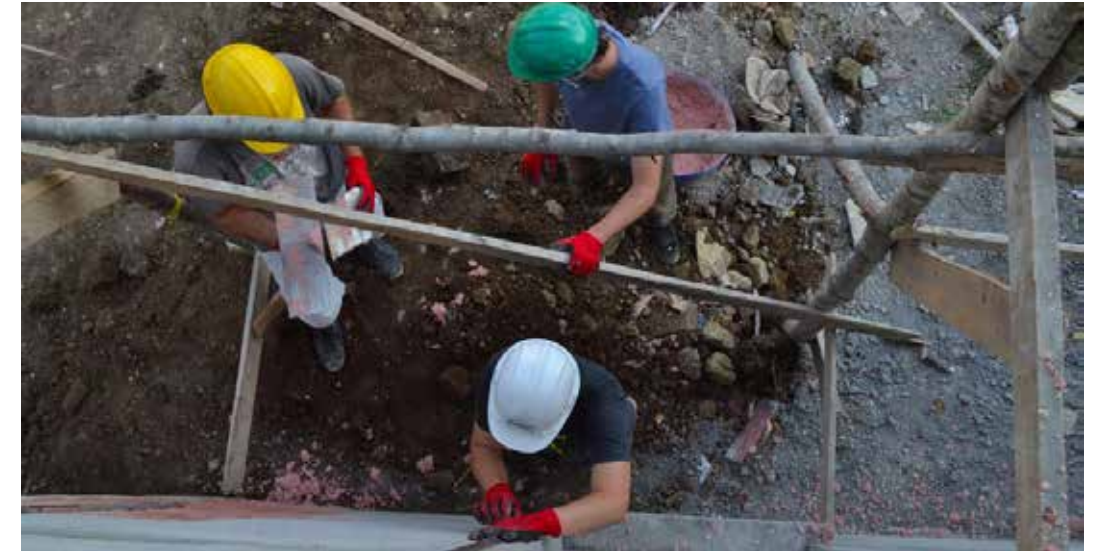
Figür 10: Kargı'da inşaat çalışmaları
