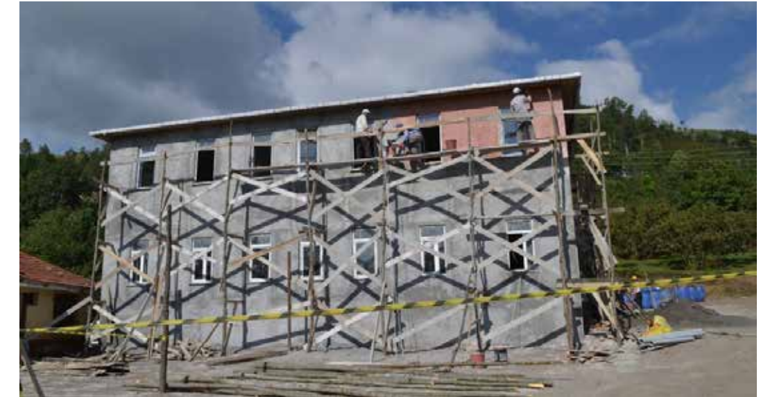
Figür 7: Ordu Kargı'da yarım kalmış okul inşaatı
