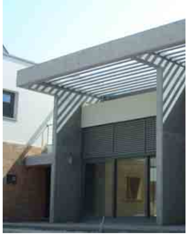
B Tipi giriş cephesi
