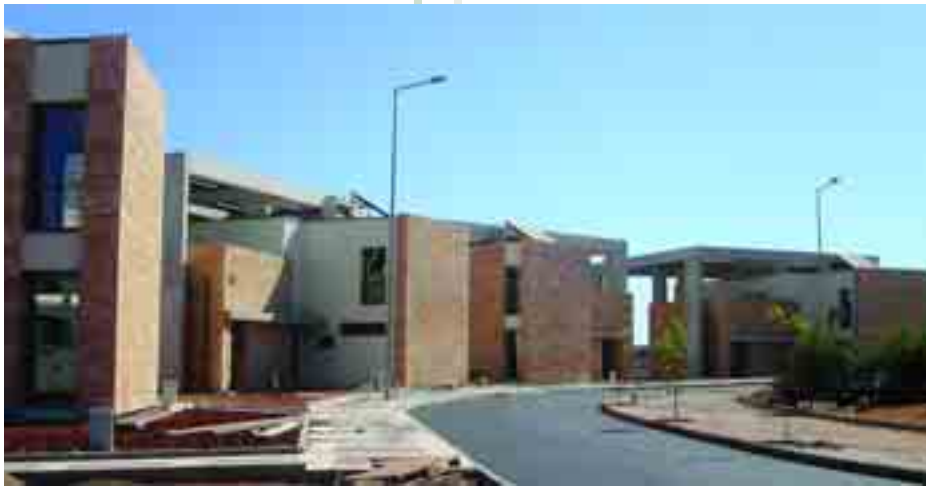
B tiplerine Giriş cephesinden görünüm
