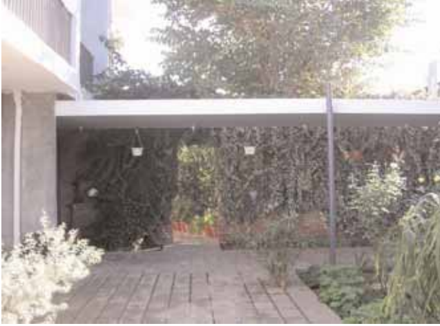
Resim 03. Ofis terasına geçit veren kırmızı tuğla duvar (foto:p.ulucay)
