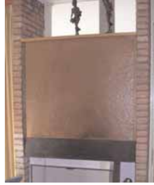
Resim 11. Şömine detayı (foto:p.ulucay)
