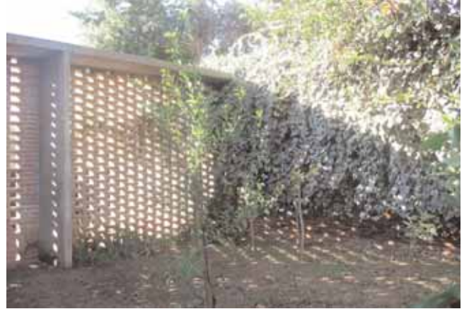
Resim 05. Ofis terasına bakan geçirgen bahçe duvarı (foto:h.pulhan)
