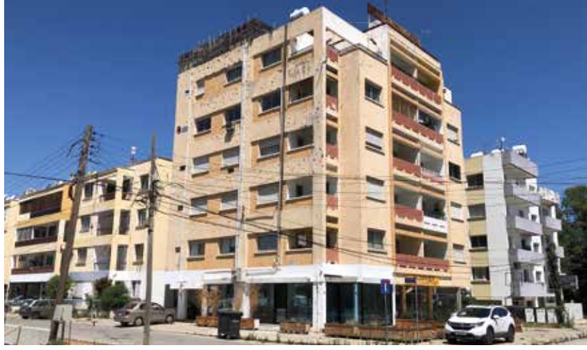
Figür 1. Temel II isimli apartman, bir harabenin yanında, 1974 yılında kurşunlanmış hali ile durmaktadır (Mimar: Abdullah Onar), Shakespeare Caddesi, Lefkoşa
