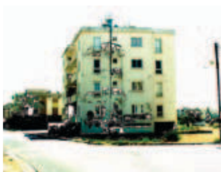
Resim 4. Temiz ve pis su tesisat boruları nedeniyle cephelerde oluşan problemler (Fotoğraflar: Kozan Uzunoğlu, Semra Sema Uzunoğlu arşivinden, 2015).
