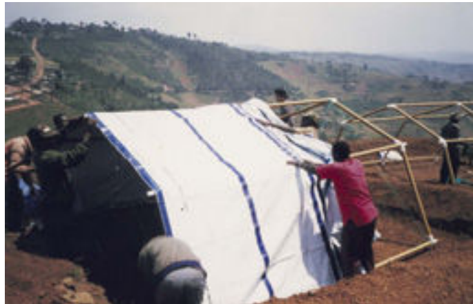
Resim 7. Shigeru Ban tarafından UNHCR için geliştirilmiş kağıttan acil durum konutu, Byumba mülteci kampı, Rwanda, 1999. http://www.archdaily.com/489255/the-humanitarian-works-of-shigeru-ban (Temmuz 2017)
