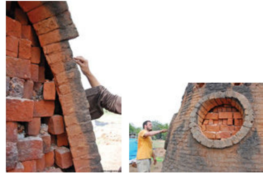
Resim 25-26. Yanma işlemi sonrasında pişmiş tuğla ürünleri çıkartmak için fırının (konutun) açılması (Kaynak: Alka Hingorani, 2011, https://archnet.org/sites/15691 ).
