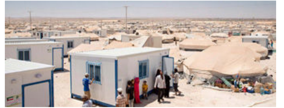
Resim 3. Zaatari Mülteci kampının iyileştirme projesinin parçası olarak geliştirilmiş prefabrike konutlar. http://www.unhcr.org/innovation/labs_post/dwelling-modification-zaatari-camp/ (Temmuz 2017)
