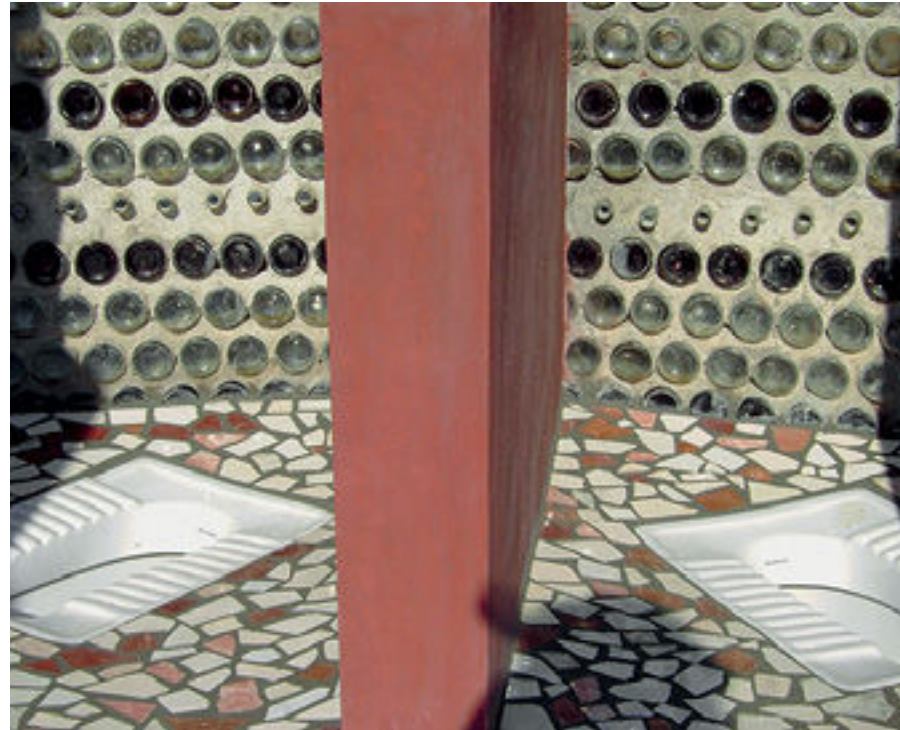
Resim 21. Islak hacimlerin duvarlarında cam şişelerden yapı elemanı (Kaynak: Sonja Winkler, 2011, https://archnet.org/sites/15691 ).
