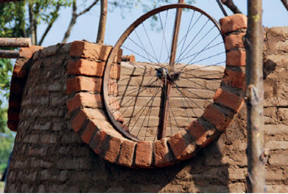
Resim 18. Bisiklet tekerleği çerçevesi pencere için kalıp görevi görüyor (Kaynak: Andres Herzog, 2008, https://archnet.org/sites/15691 ).
