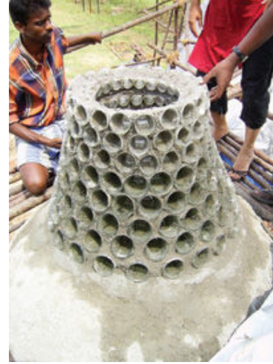
Resim 24. Yanma işleminin gerçekleşmesini sağlayacak hava dolaşımına olanak sağlayan fırın (konut) içerisinde kümelenmiş tuğla ürünler (Kaynak: Andres Herzog, 2011, https://archnet.org/sites/15691 ).
