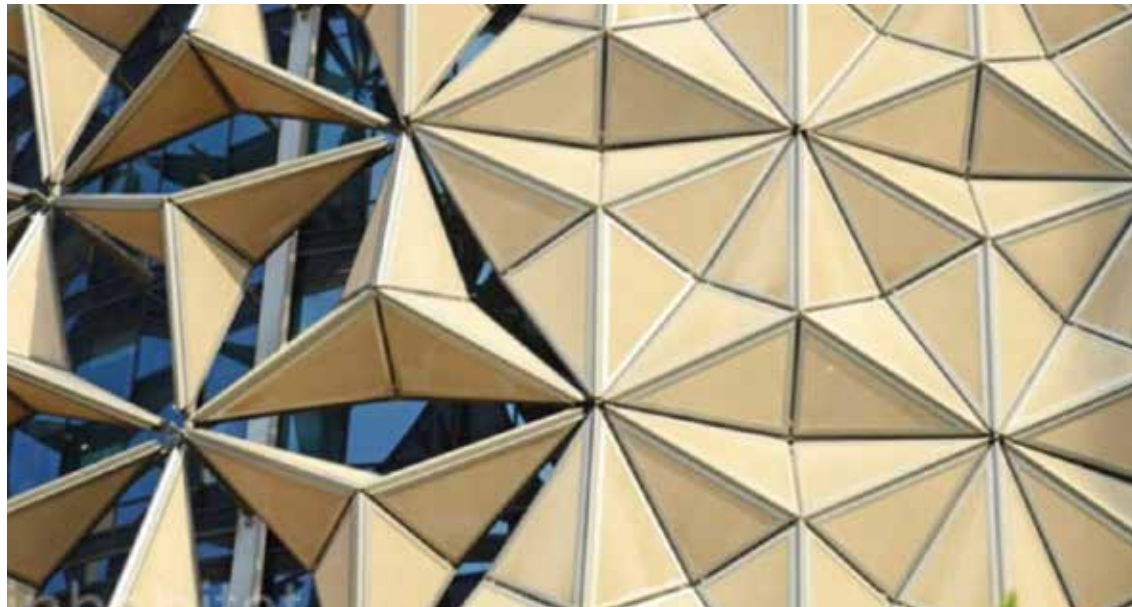
Şekil 3. Al-Bahr Kinetik Cephe Detayı (Kaynak: Exclusive Photos: World's Largest Computerized Façade Cools Aedas' Al Bahr Towers)
