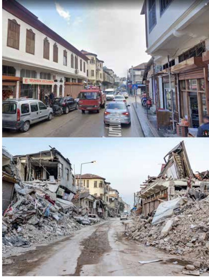
Figur 3. Kurtuluş Caddesi, Antakya. Öncesi: Google Street View / Sonrası: Murat Germen, 2023.
