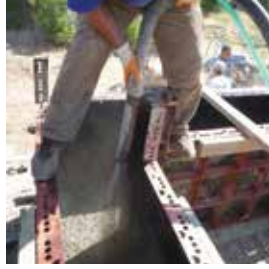
Resim 17. Dilekkaya karma kerpiç yapı, a.sarı taş döşenmesi, b.kalıbın doldurulması, c. şantiye.
