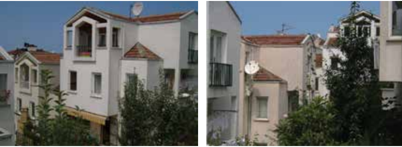
Resim 19. ve 20. Cephe ve çatı görünüşü.
