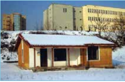
Resim 5. Ayazağa, kerpiç pilot.2. / Resim 6. Ayazağa, kerpiç pilot.2 yapısı inşaatı.
