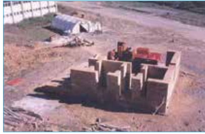
Resim 5. Ayazağa, kerpiç pilot.2. / Resim 6. Ayazağa, kerpiç pilot.2 yapısı inşaatı.
