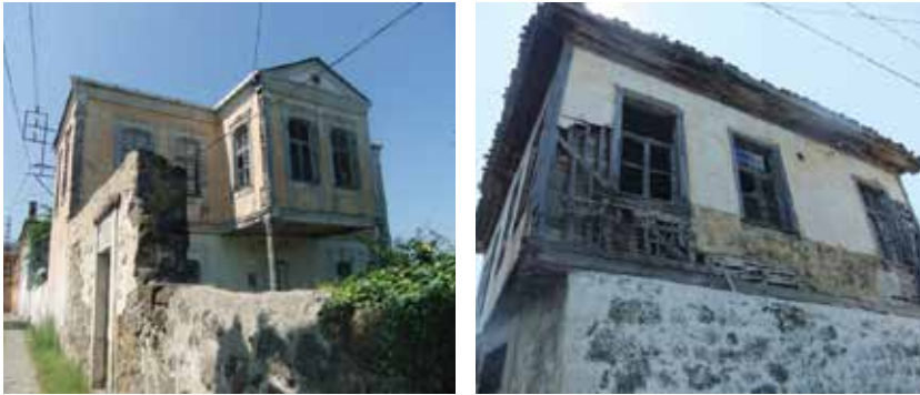
Resim 12. ve 13. Taş tekniği ve ahşap çatkı-bağdadi tekniği.
