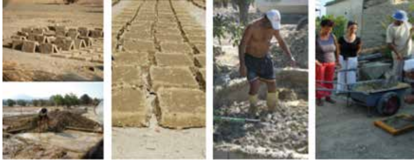
Resim 4. Geleneksel kerpiç üretim süreci. a.kurutma aşaması, b.havuzda dinlendirme, c.kerpiç keme yeri, d.harç karıştırma-ayak ile ezerek. e.kerpiç kalıbı (Özge Özbekoğlu inşaatı, Büyükkonuk 2006).
