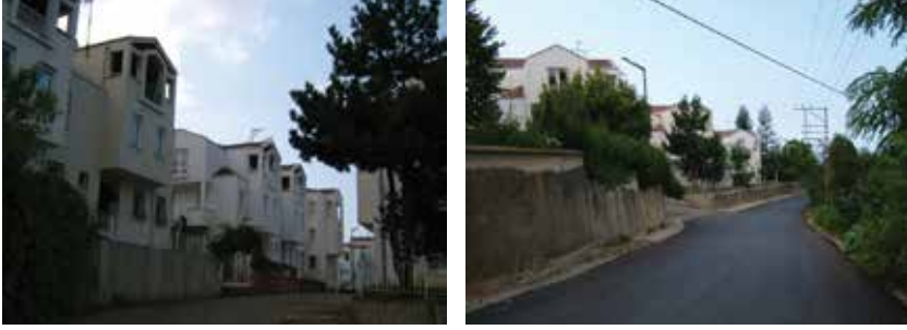
Resim 17. ve 18. Evlerin genel görünüşü ve bahçe duvarları.
