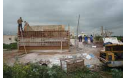
Resim 15. Dilekkaya karma kerpiç yapı - dışta kerpiç duvarlar (PERI) kalıbı. Resim 16. Dilekkaya karma kerpiç yapı-dışta kerpiç duvarlar shot-crete tekniği ile üretim.
