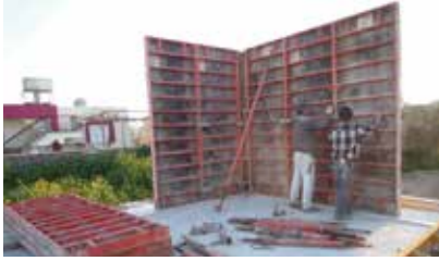
Resim 15. Dilekkaya karma kerpiç yapı - dışta kerpiç duvarlar (PERI) kalıbı. Resim 16. Dilekkaya karma kerpiç yapı-dışta kerpiç duvarlar shot-crete tekniği ile üretim.
