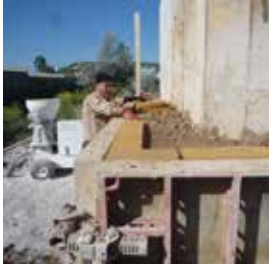
Resim 17. Dilekkaya karma kerpiç yapı, a.sarı taş döşenmesi, b.kalıbın doldurulması, c. şantiye.
