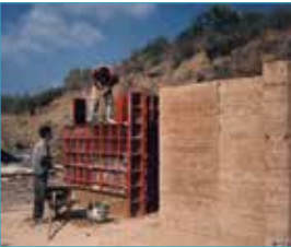
Resim 7. Ayazağa, kerpiç pilot.2, PERI kalıbı. Resim 8. harç karıştırma. Resim 9. Tokmıklama.
