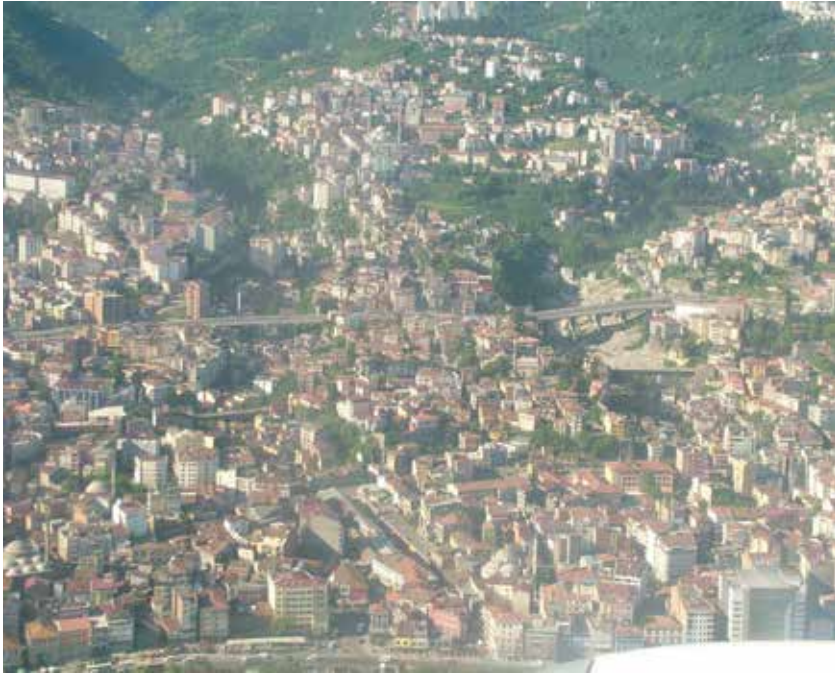
Resim 4. Aynı bölgeyi gösterir, kuzeyden güneye doğru 2006 yılında çekilen bir resim. Zağnos vadisinde kamulaştırılan binaların yıkım işlemlerine başlanmış, TOKİ konut inşaatlarına henüz başlamamıştır.
