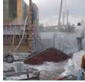
Resim 17. Dilekkaya karma kerpiç yapı, a.sarı taş döşenmesi, b.kalıbın doldurulması, c. şantiye.
