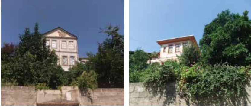
Resim 10. ve 11. Bahçe duvarları görünüşü.
